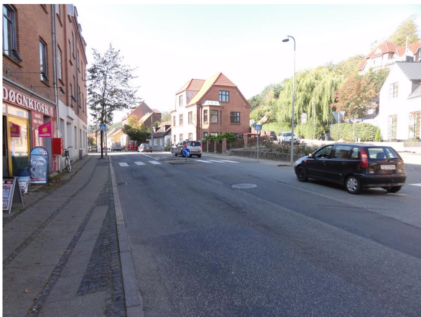
Eksempel på fodgængerfelt med støttepunkt i Vejle.
