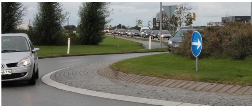
Eksempel på rundkørsel i åbent land på H425 syd for Struer
