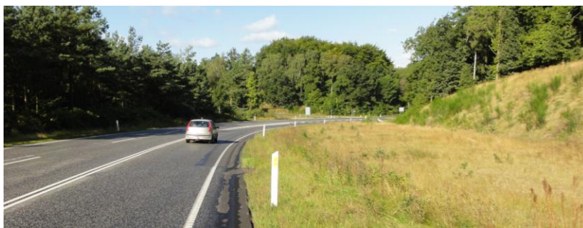
Eksempel på sikring af sideområder fra H413 nord for Ebeltoft.
